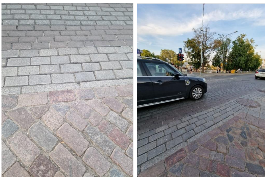
2.2.1.14.attēls. Gājēju un velo krustošanas zona, izmantojot akmens bruģi Tartu pilsētā, Igaunijā (autora foto, 2023.gads)
