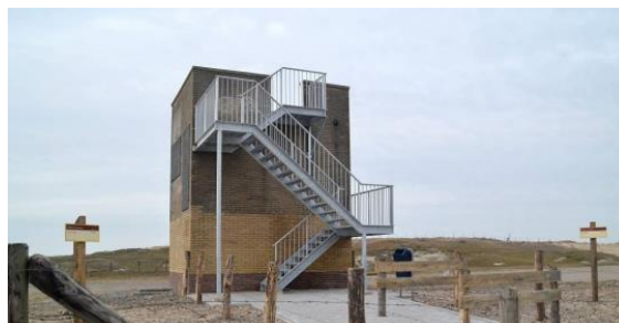
5.attēls Revitalising Noordduinen, militārā ēka pārbūvēta par skatu torni.
