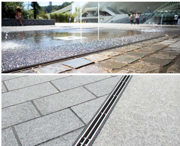
2.2.1.10.attēls. Līnijveida ar BrickSlot režģi un Multiline notekas 83
