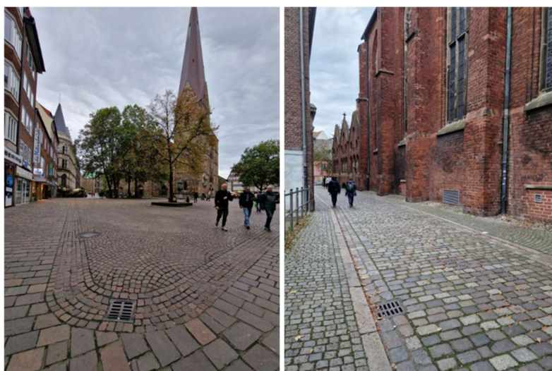
2.2.1.9.attēls. Lietusūdens risinājumi Brēmenes vecpilsētu ielās (autoru foto 2022.g.)
