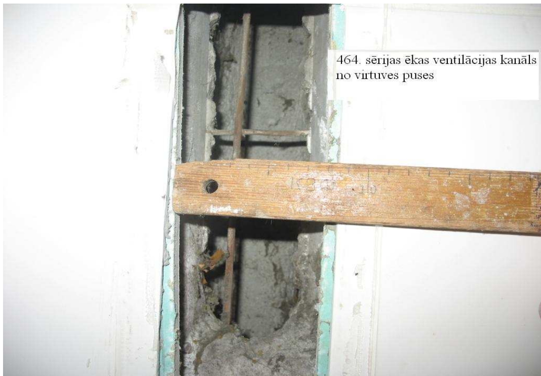
Ventilācijas kanāla esošais pieslēgums no virtuves puses
