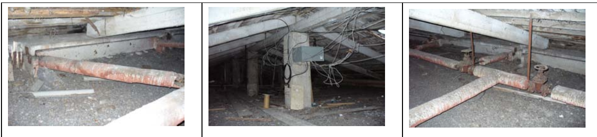
Divslīpju jumta gala slīpnes konstrukcija:
