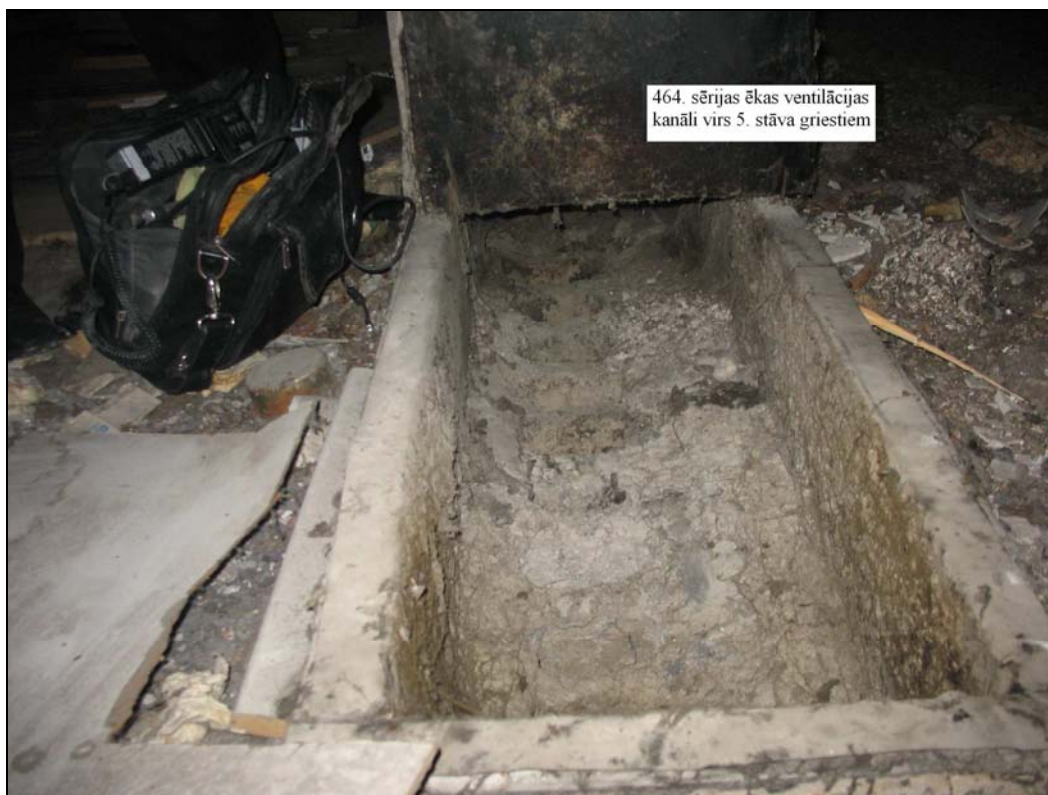
464. sērijas ēkas ventilācijas kanāli virs 5.stāva griestiem
