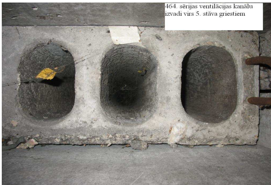
464. sērijas ēkas ventilācijas kanāli virs 5.stāva griestiem
