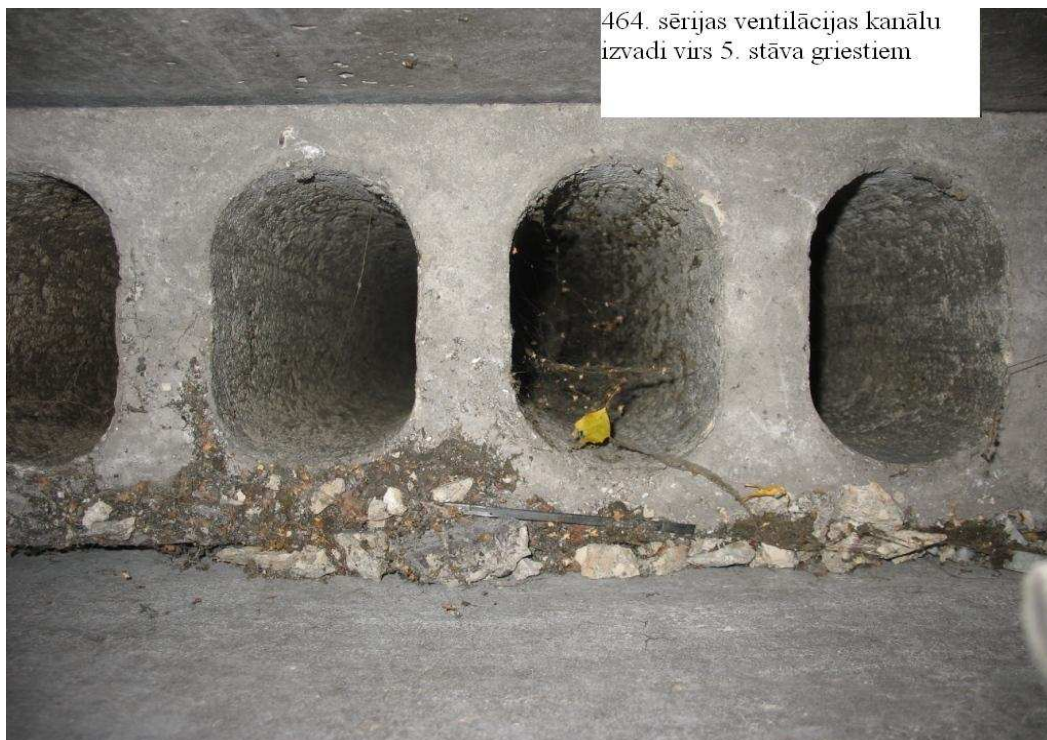
464. sērijas ēkas ventilācijas kanāli virs 5.stāva griestiem
