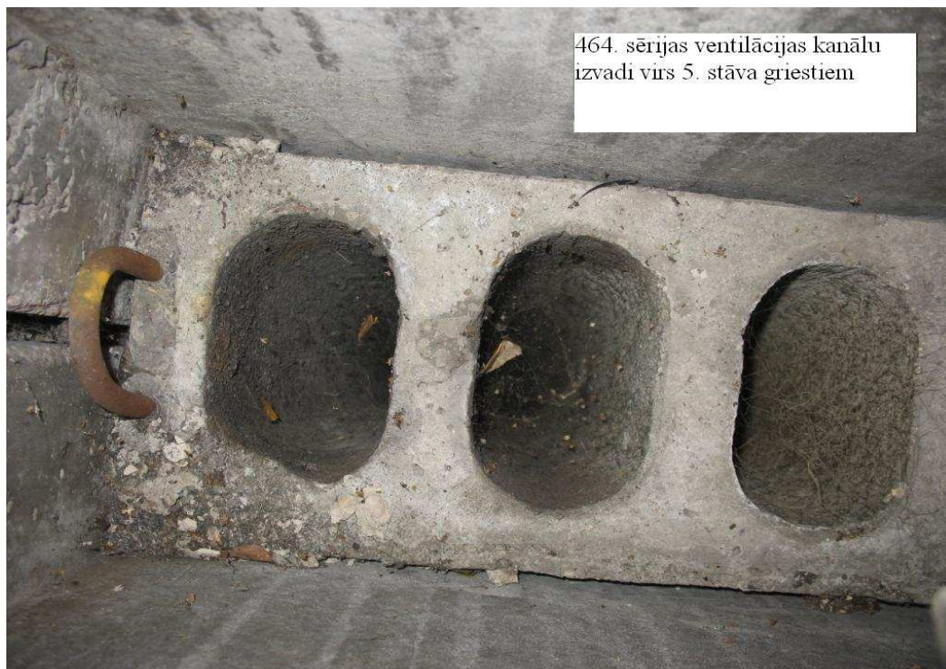
464. sērijas ēkas ventilācijas kanāli virs 5.stāva griestiem
