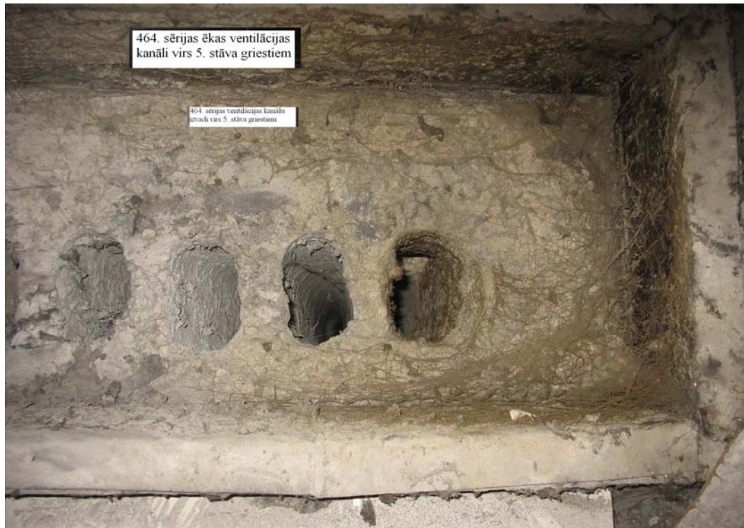
464. sērijas ēkas ventilācijas kanāli virs 5.stāva griestiem
