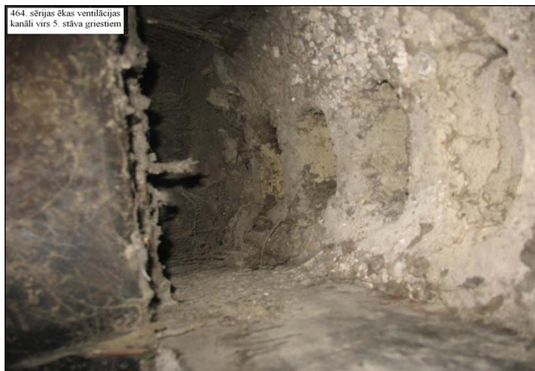
464. sērijas ēkas ventilācijas kanāli virs 5.stāva griestiem
