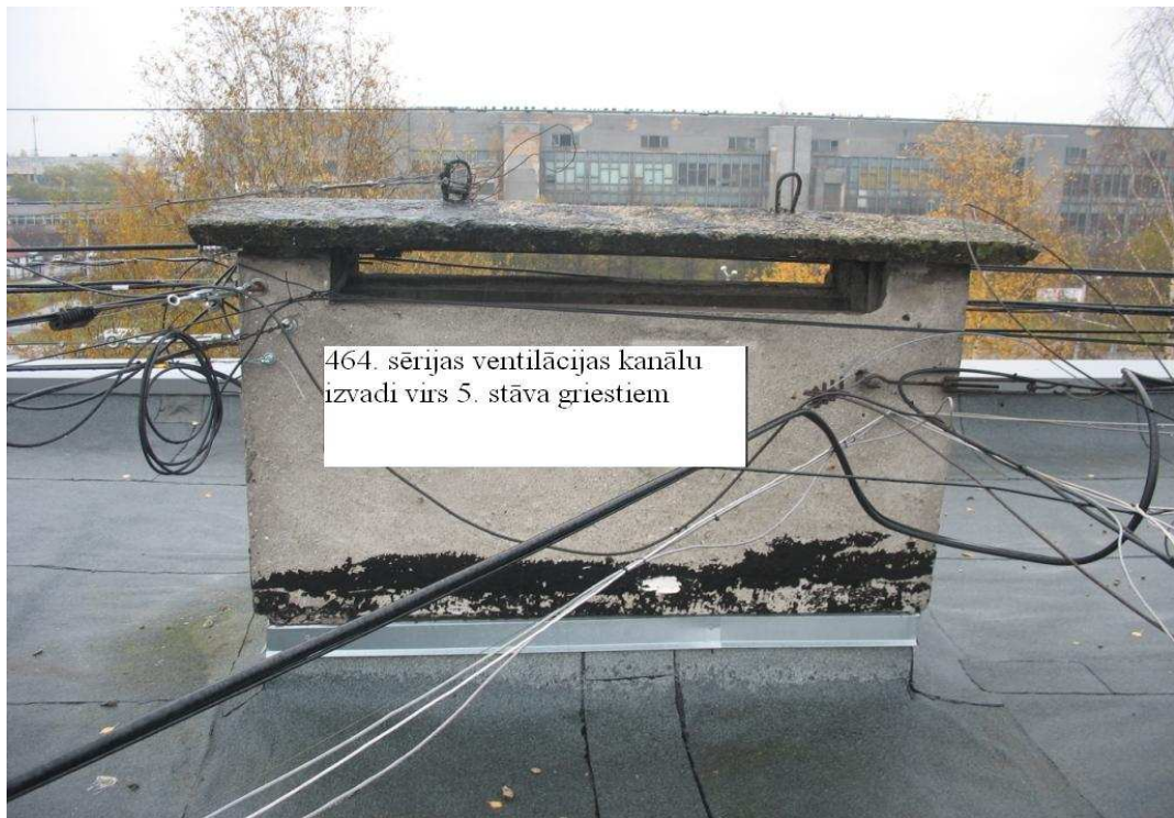
464. sērijas ēkas ventilācijas kanālu izvads virs jumta
