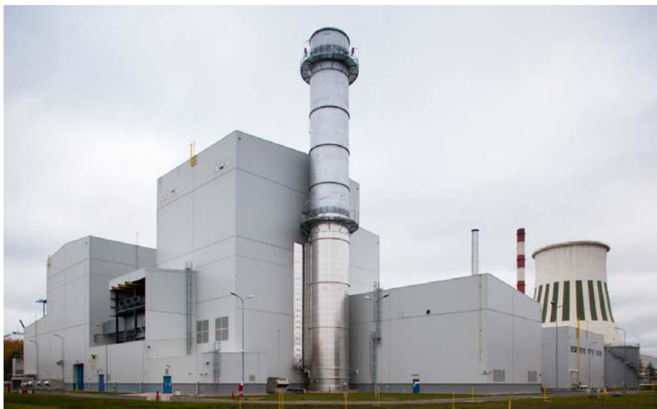
9.19.attēls:Rīgas TEC2 otrais CCGT energobloks. Avots: AS „Latvenergo”
