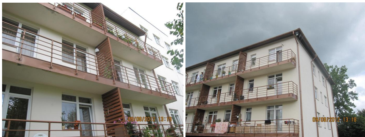
Attēls Nr. 1. Dzīvojamā ēka Pasta ielā 4, Baldonē
