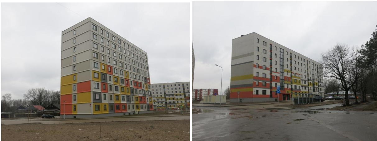
Attēls Nr. 14. Dzīvojamās ēkas Mežrozīšu ielā 22; 26; 28 un 30, Rīgā
