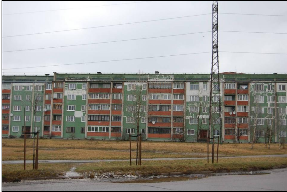
Attēls nr. 9-5 Dzīvojamās daudzstāvu paneļu mājas Lielupes ielā, Bolderājā ārpus RBO
