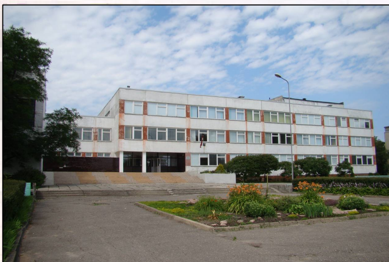
Rīgas 84. vidusskola Lielvārdes ielā 141
