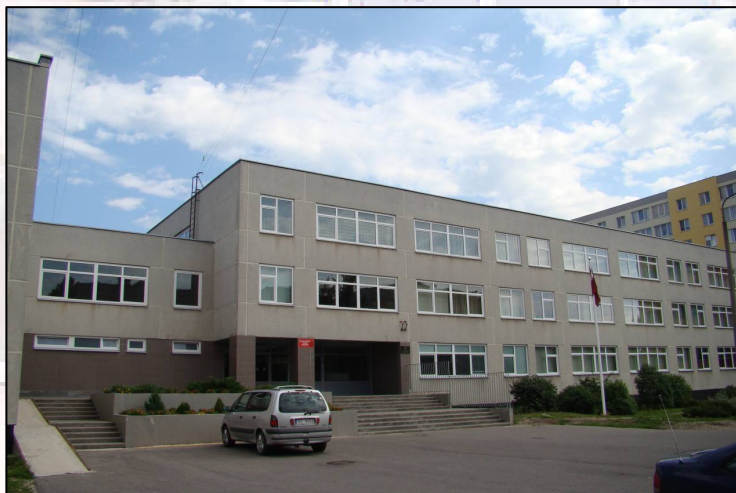
Rīgas Purvciema ģimnāzija D.Brantkalna ielā 5
