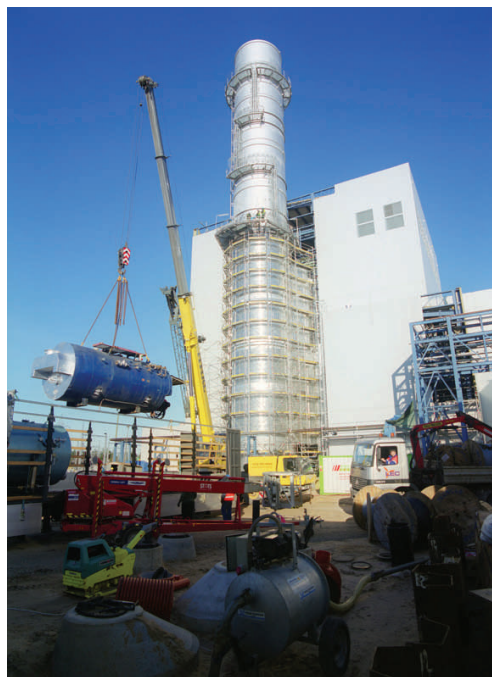
1. attēls. TEC-2 rekonstrukcijas darbi
