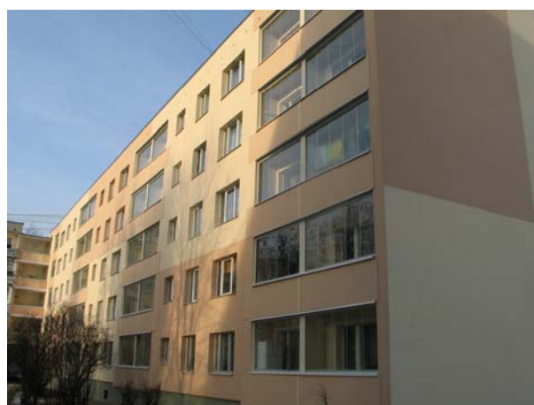
Attēlā: Siltināta dzīvojamā ēka Kurzemes prospektā 4 (2008.g.)
