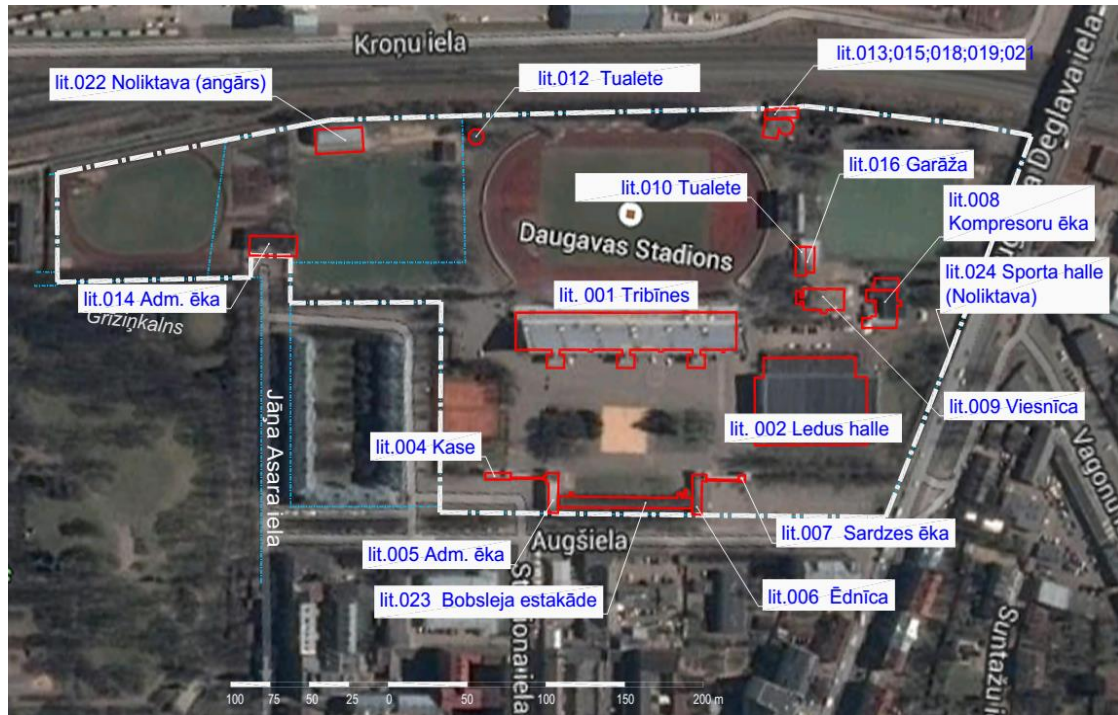
Attēls 10. Apsekotās DS teritorijas ēkas un būves
