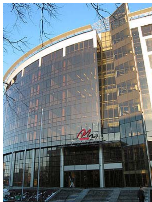
Att. 10. LMT birojs Ropažu ielā 6
