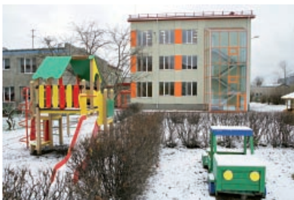
Rīgas 213. pirmsskolas izglītības iestādes trīsstāvu piebūve
