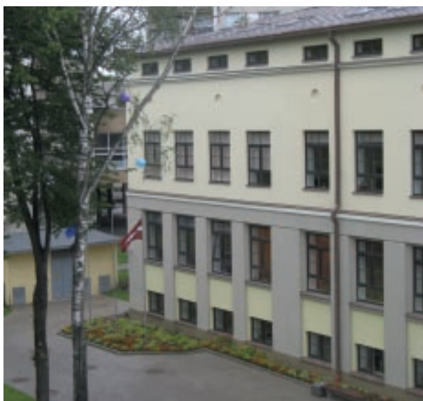
Andreja Pumpura Rīgas 11. pamatskolas rekonstruētā ēka
