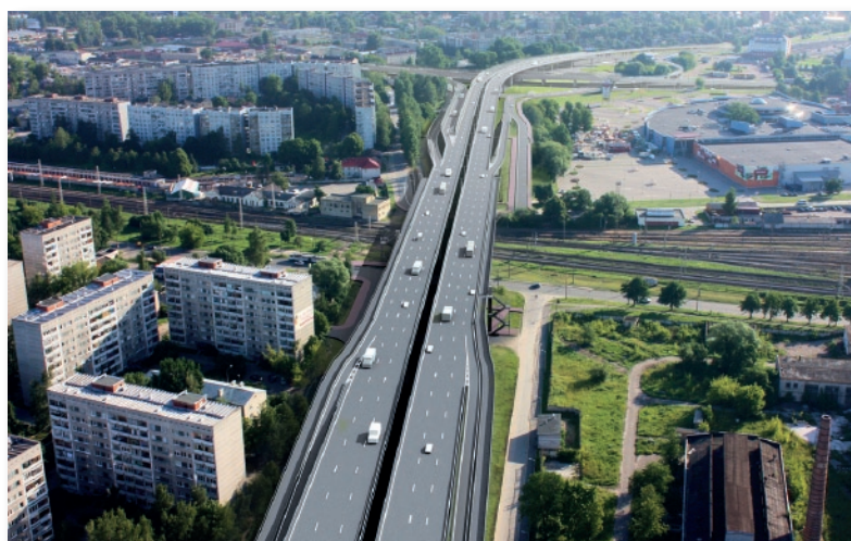
Slāvu ielas dzelzceļa pārvads 2009. un 2011. gadā.
