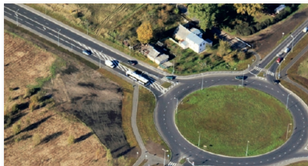
2010. gada pabeigta Juglas ielas izbūve.
