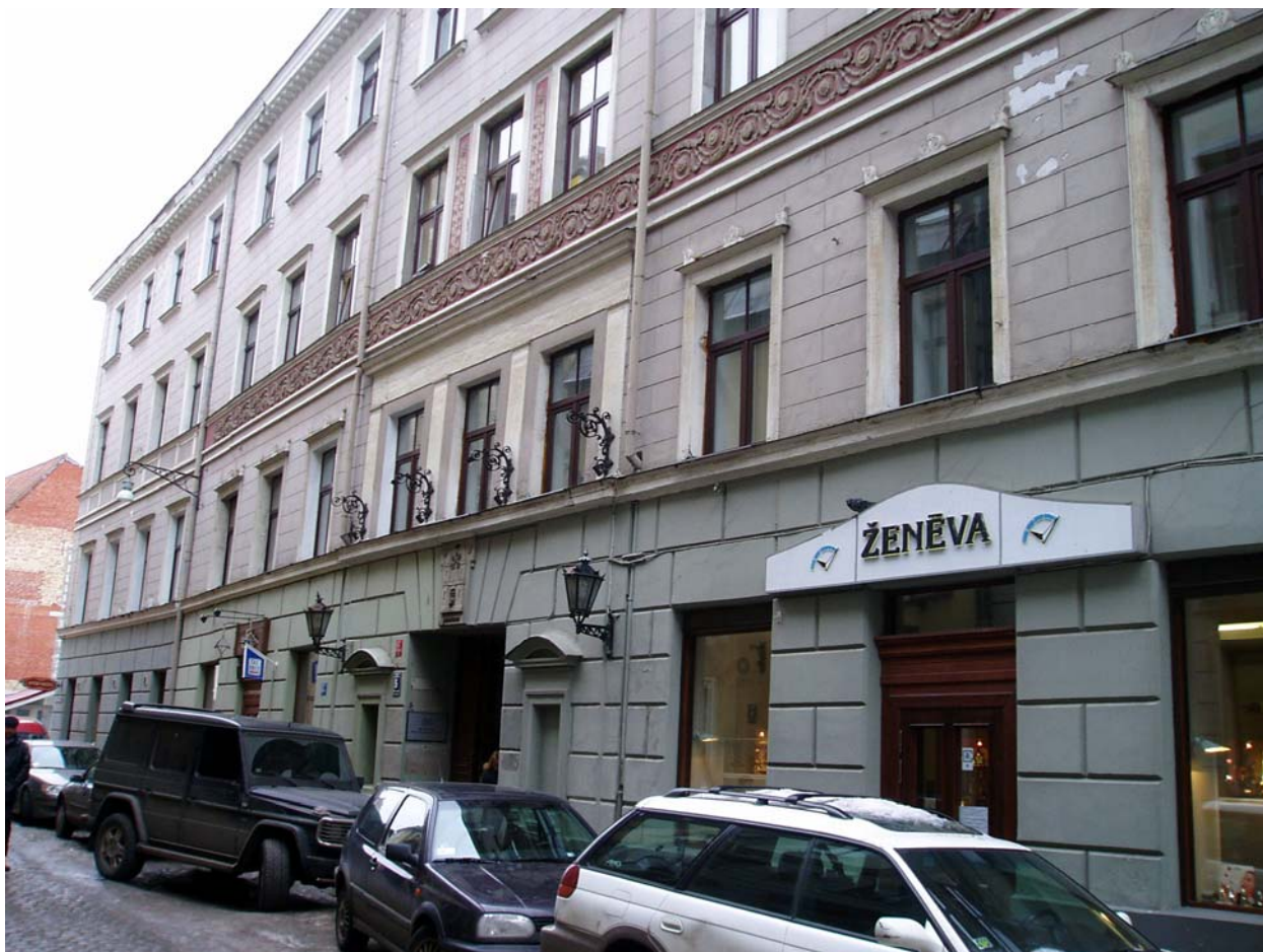
24. attēls – ēka R. Vāgnera ielā 5 (privāta fotogrāfa foto)
