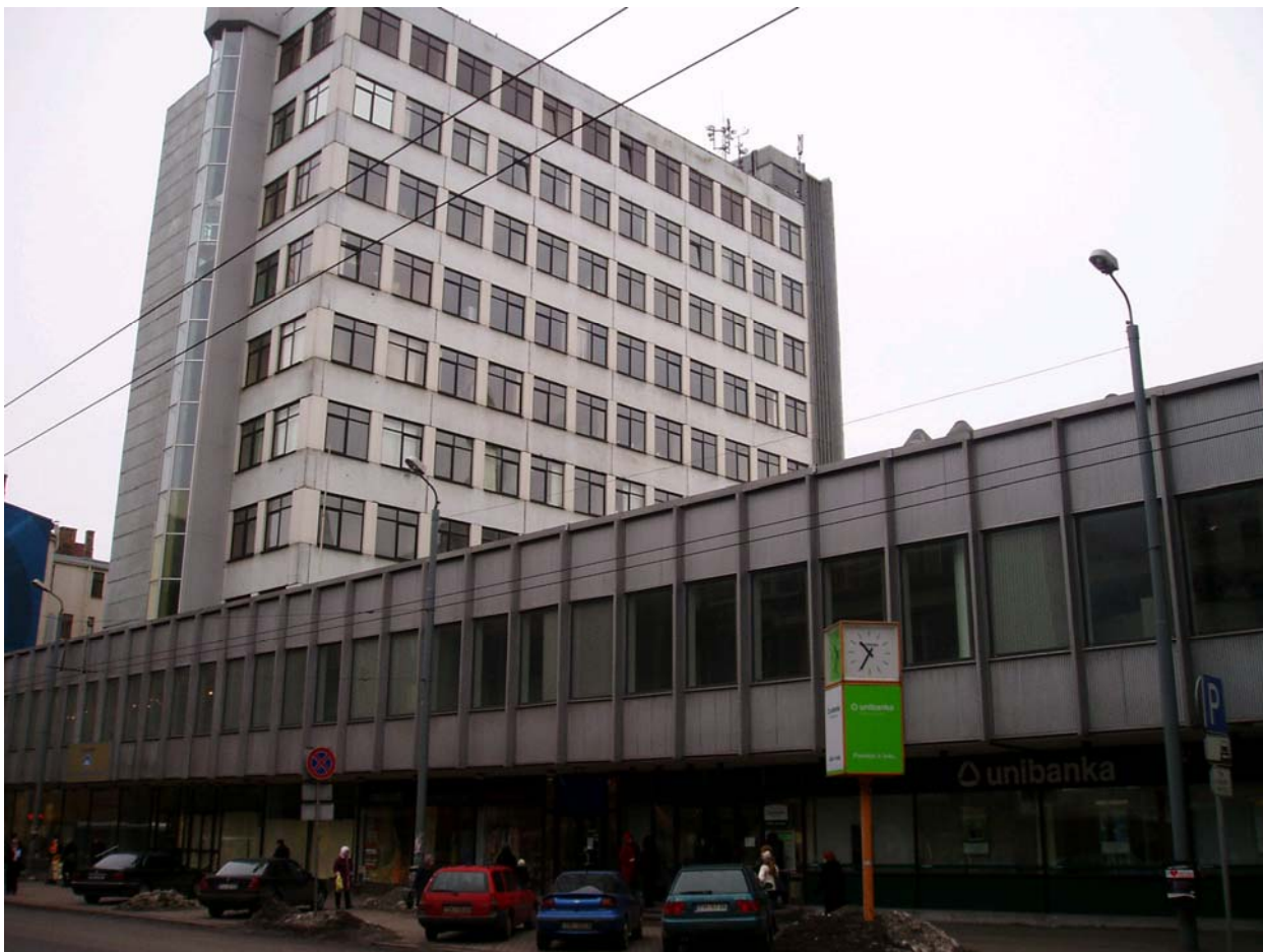
29. attēls – ēka Brīvības ielā 49/53 (privāta fotogrāfa foto)
