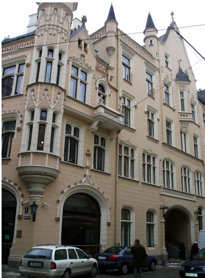
23. attēls – ēka Amatu ielā 4 (privāta fotogrāfa foto)
