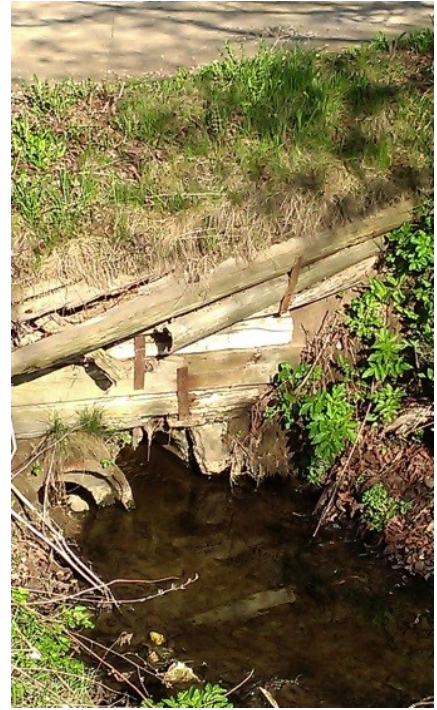
68. attēls. Novadgrāvja N-17 caurteka Jāņogu ielā pie Dārziņu 22. līnijas. Avots: "Metrum".
