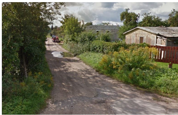
63. attēls. Novadgrāvja N-5 posms Dārziņu 3.līnijas un Dārziņu ielas krustojumā. Skats novadgrāvja lejtecē virzienā. Avots: "Metrum".
