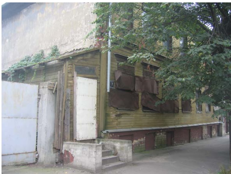
Attēls 2.2. Ēku tehniskais stāvoklis ir ārkārtīgi slikts, gadu gaitā tās pārvērtušās graustos.
