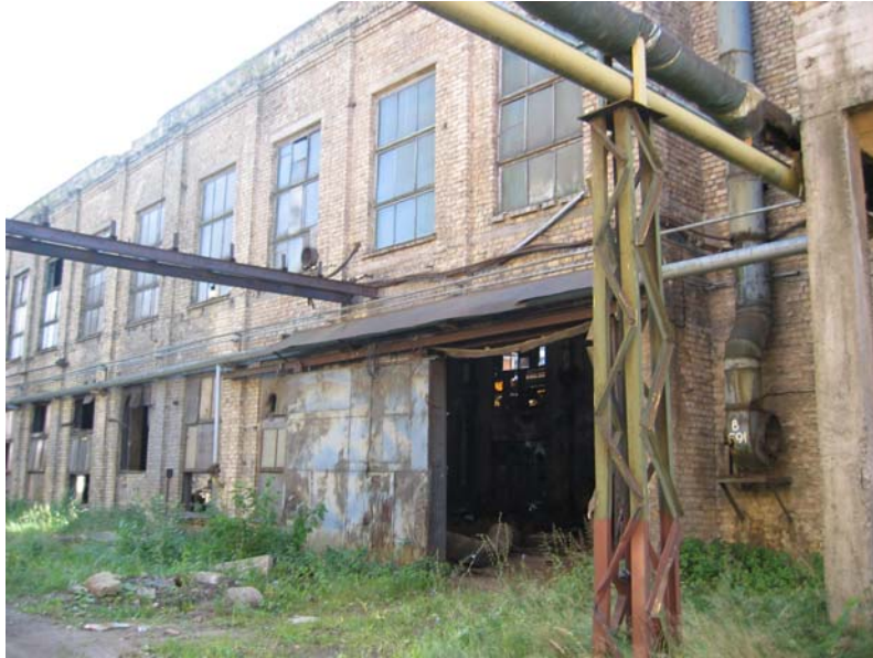
Attēls 3.1. Bijušās rūpnīcas iekārtu demontāža ir sarežģīta, darbietilpīga un dārga.
